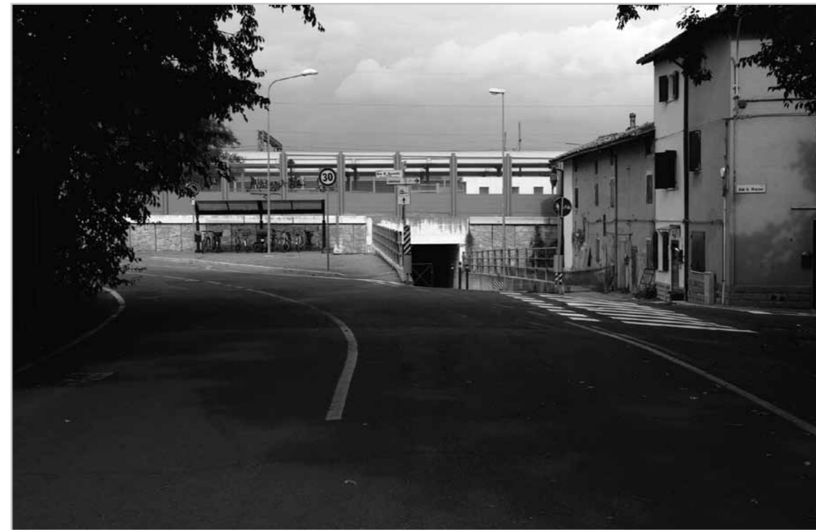
La zona è completamente trasformata: non ci sono più la casella e la torretta; al posto delle sbarre e di un passaggio a livello anche per auto, ora ci sono un sottopasso per pedoni e cicli, la ferrovia sopraelevata e la tangenziale alla via Emilia con le barriere antirumore
