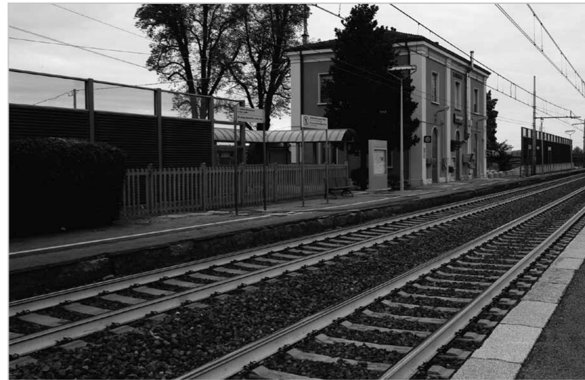
Una parte di verde è stata sostituita da una barriera antirumore
