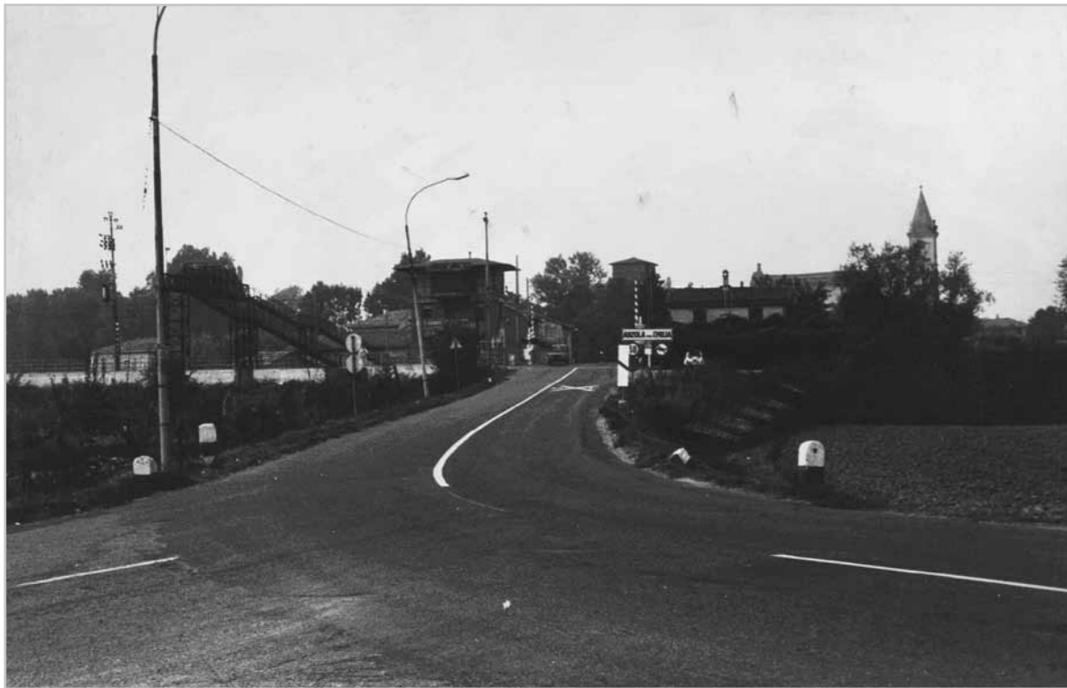
Il passaggio a livello con il cartello segnaletico di Anzola, il passaggio pedonale sopraelevato
