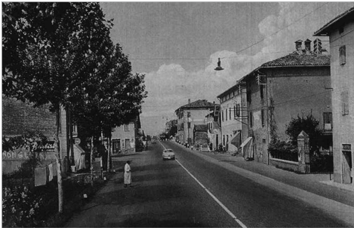
Venendo da Bologna, sulla sinistra, prima del Ponte, si scorge la trattoria Ballarini; sulla destra, fra i vari edifici, la sagoma dell'oratorio
